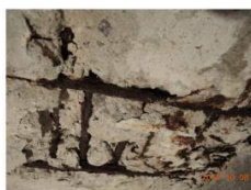
Bilde 2: Løstoppet i 10' bassengkanten. Avviket består av tykke korroderte armerings
